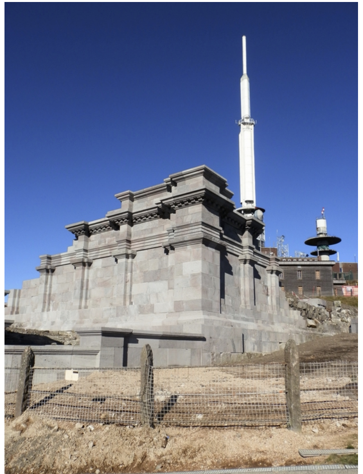
Travaux de « reconstruction » d'une partie de l'angle sud-est du temple de Mercure (sommet du Puy de Dôme)
